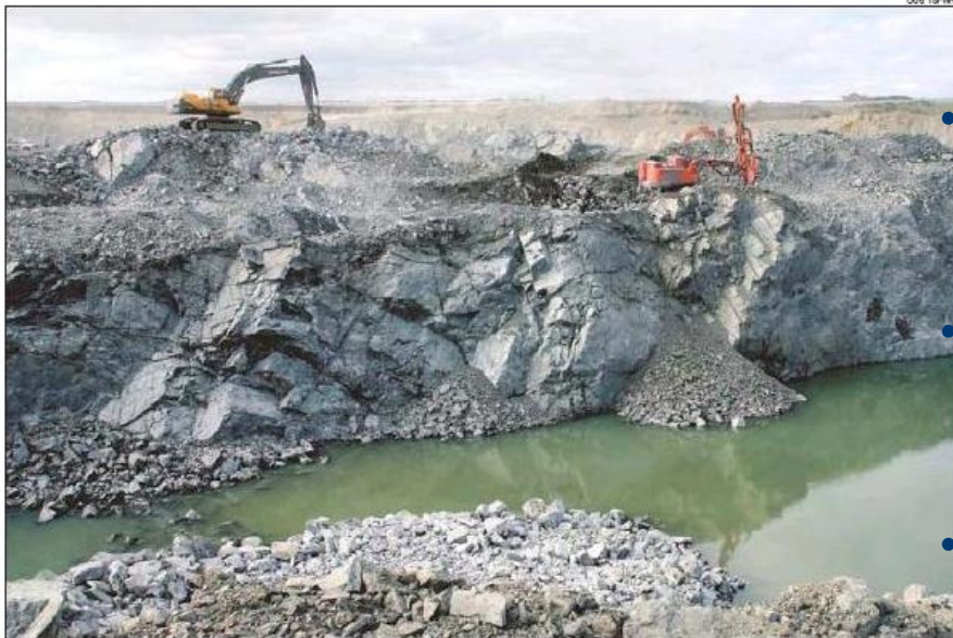
Suurkuusikon kultakaivoksesta tulee edelläkävijä kaivosvesien uuden mittaustien soveltajana. Ensimmäiset laitteet on jo alkuun asennettu.
